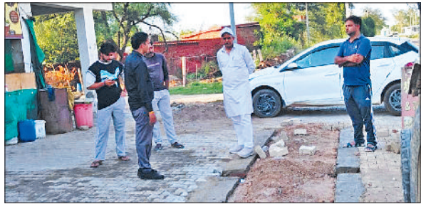
बवानीखेड़ा। निर्माण कार्यों का निरीक्षण करते हुए।
